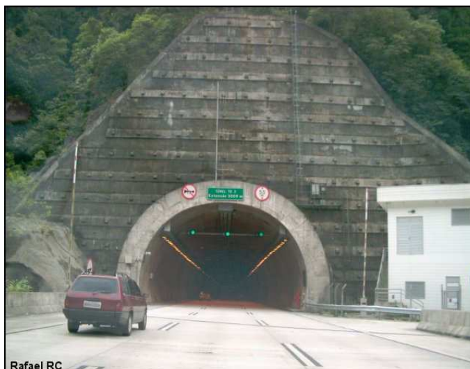
Figura 2 - Sinalização na entrada do túnel
