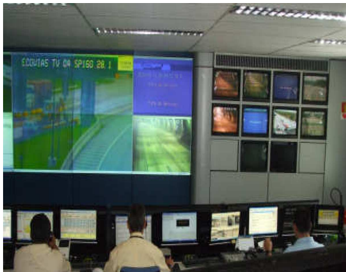
Figura 3 - Central de monitoramento
