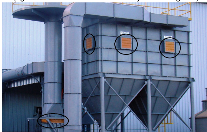
(figura exemplificativa – dispositivos de alívio de explosão)
