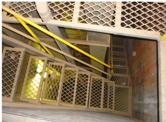
(figuras exemplificativa e ilustrativa – escada em “U” para entrada no poço do elevador e alçapão)
