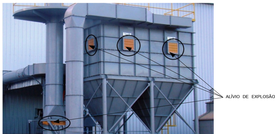
(Figura 7 – dispositivos de alívio de explosão)
