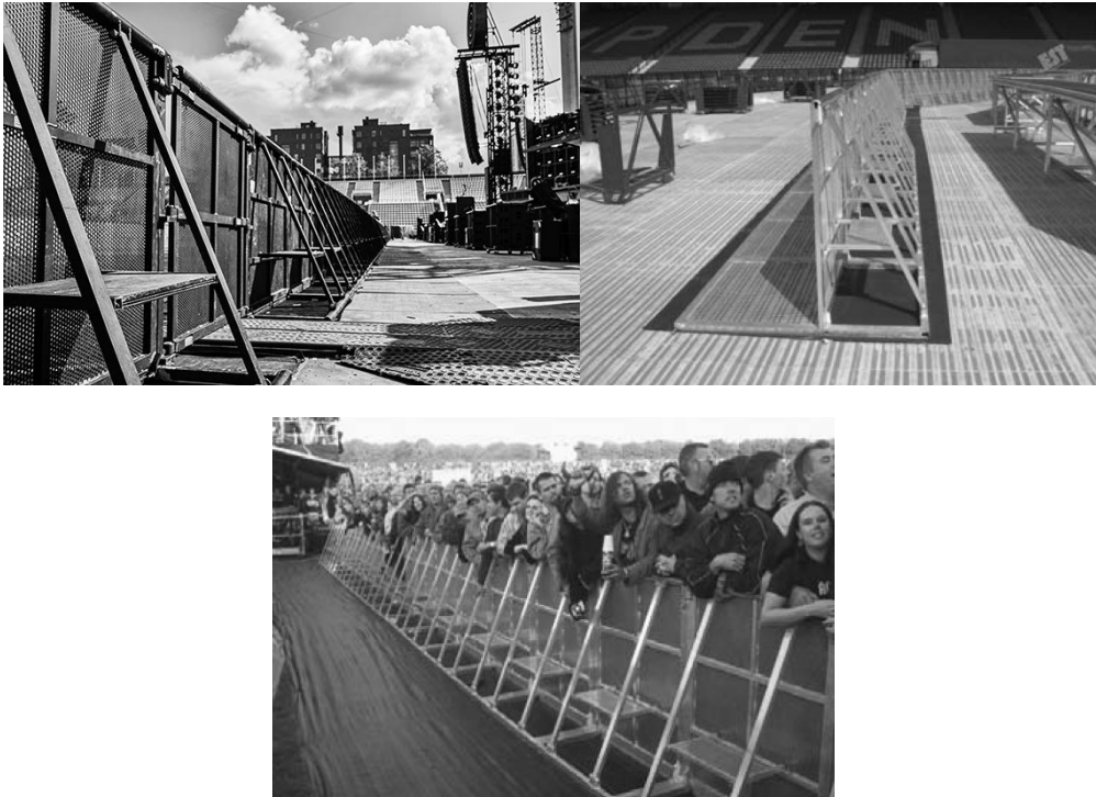
Figura 5 – Exemplos de barreira antiesmagamento
